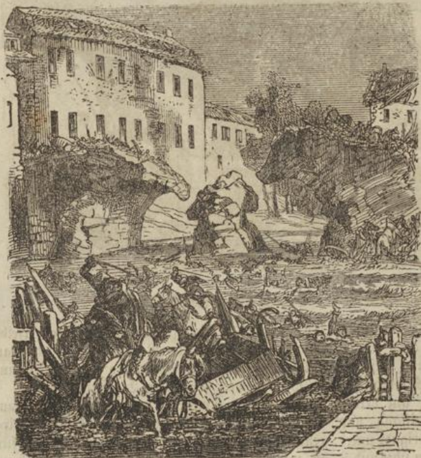
Die Trümmer der gesprengten Elsterbrücke.
