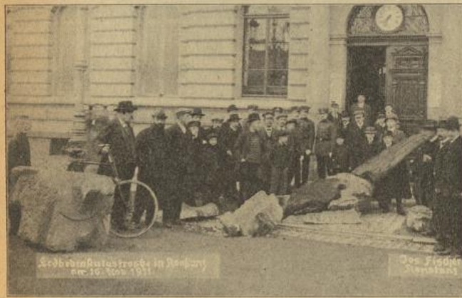
Zur Erdbeben-Katastrophe in Süddeutschland am 16. November 1911: Beschädigung des Ober-Postdirektionsgebäudes in Konstanz.
