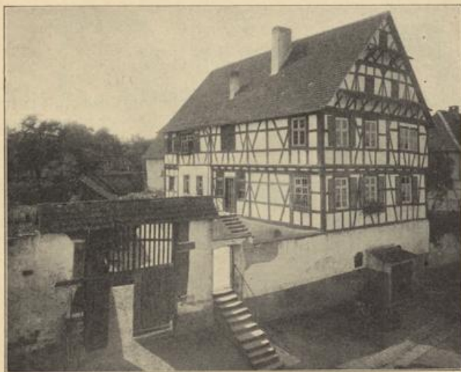
Fig. 137. Fachwerkhaus Nr. 7, ehem. Pfarrhaus zu Unteröwisheim.
