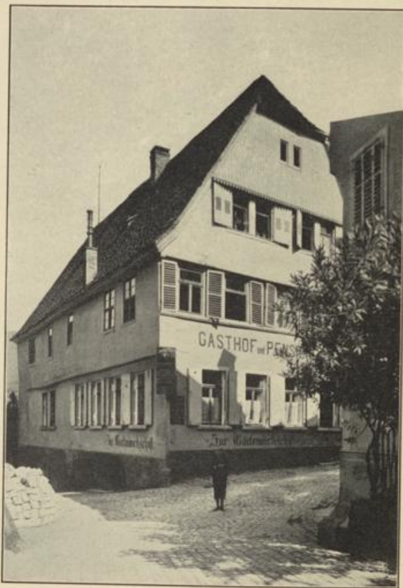
Fig. 383. Gasthaus „Zur Pfalz“ in Neckargemünd. (Früherer Zustand.)
