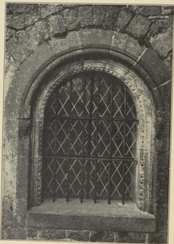
Fig. 361. Fenster unten an der Westseite des nördlichen Querarms der Klosterkirche zu Lobenfeld.
