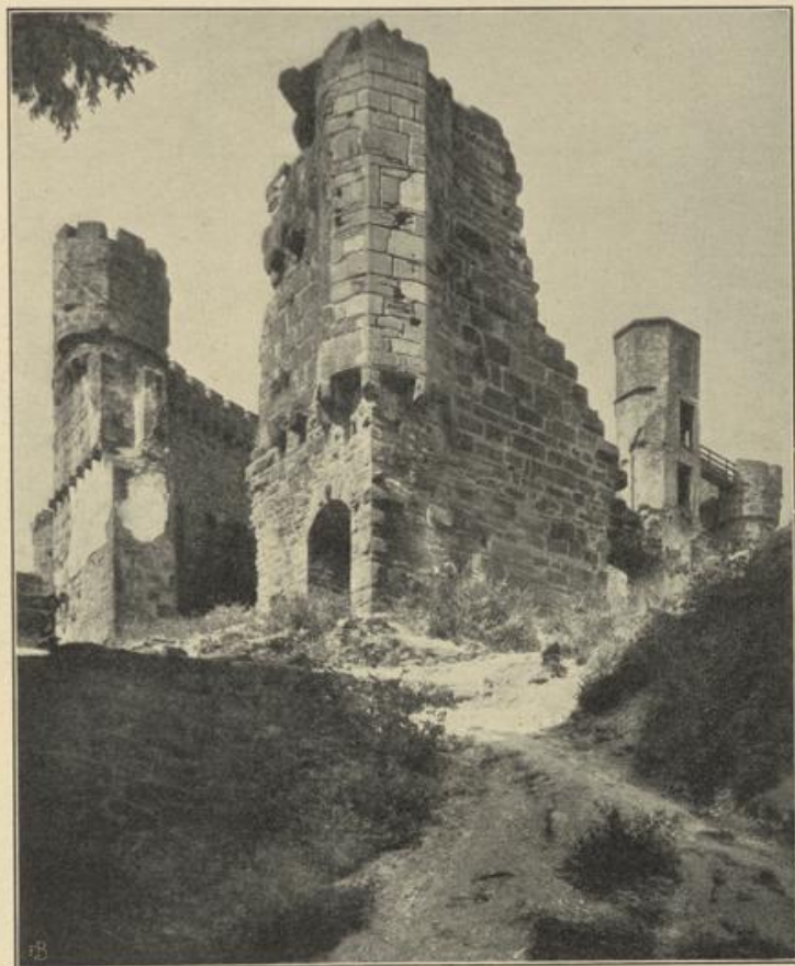
Fig. 12. Südlicher Teil des Mantels der Oberburg Dilsberg.
