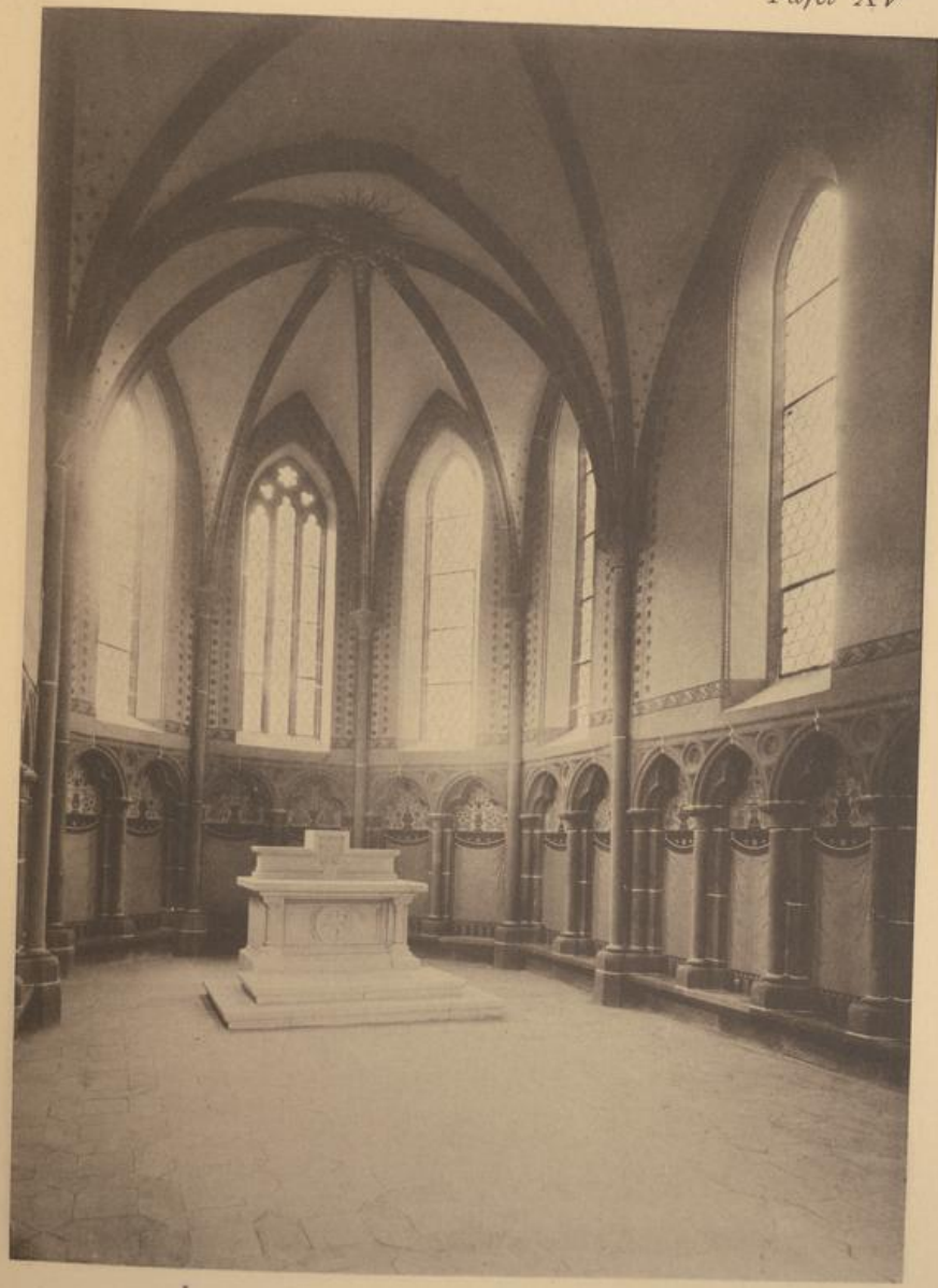
Thennenbach. Kapelle, Innenansicht (nach der Restauration).
