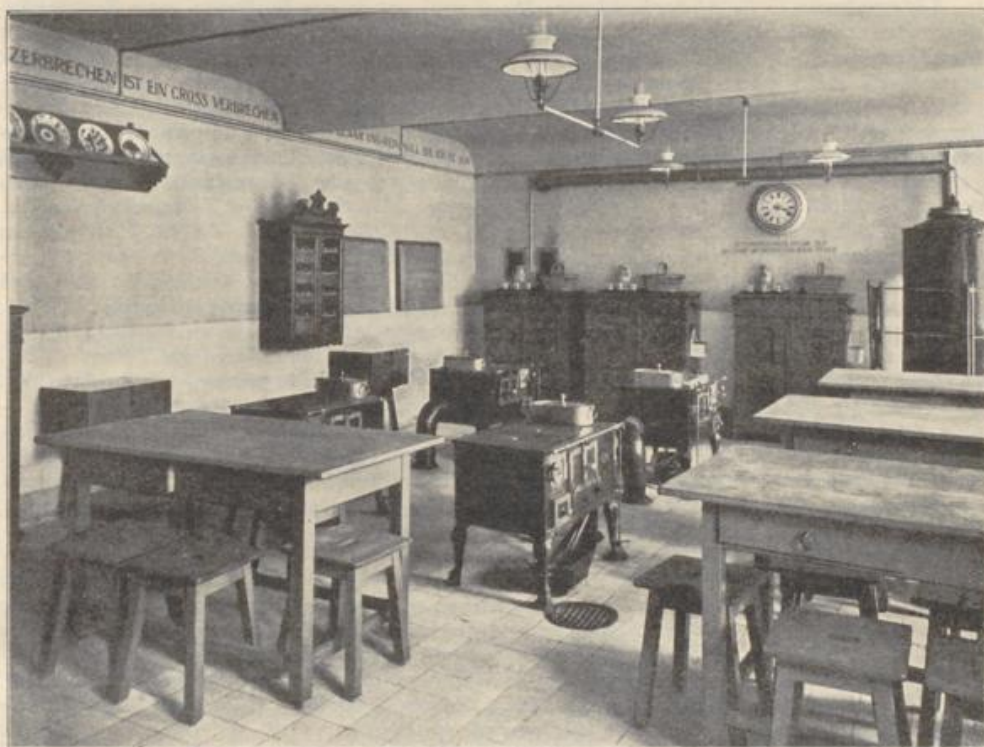
Schulküche in einer Karlsruher Volksschule.
