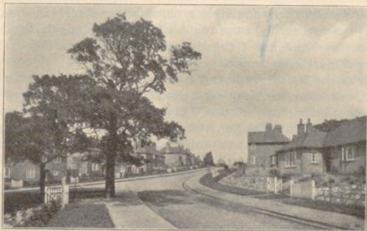
Abb. 25. Straße in dem Fabrikgartendorf Bournville.
