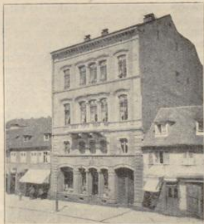
Viergeschossiges Haus, das 1861 auf dem Boden des nebenstehend abgebildeten Hauses erbaut wurde.
