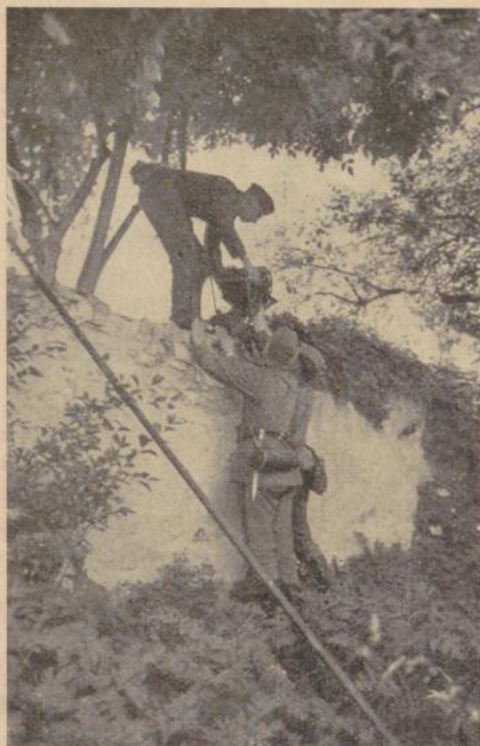
Nachrichten-Abteilung beim Leitungsbau.
