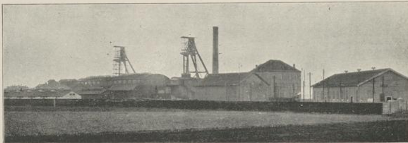
Schachtanlagen der Grube St. Maria.
