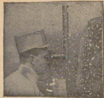
Abb. 12. Das Reichert'sche Schützengraben-Periskop auf ein Prismenbinokel aufgesetzt, im Gebrauch.
