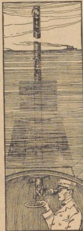
Abb. 15. Das Sehrohr (Periskop) der Unterseeboote.
