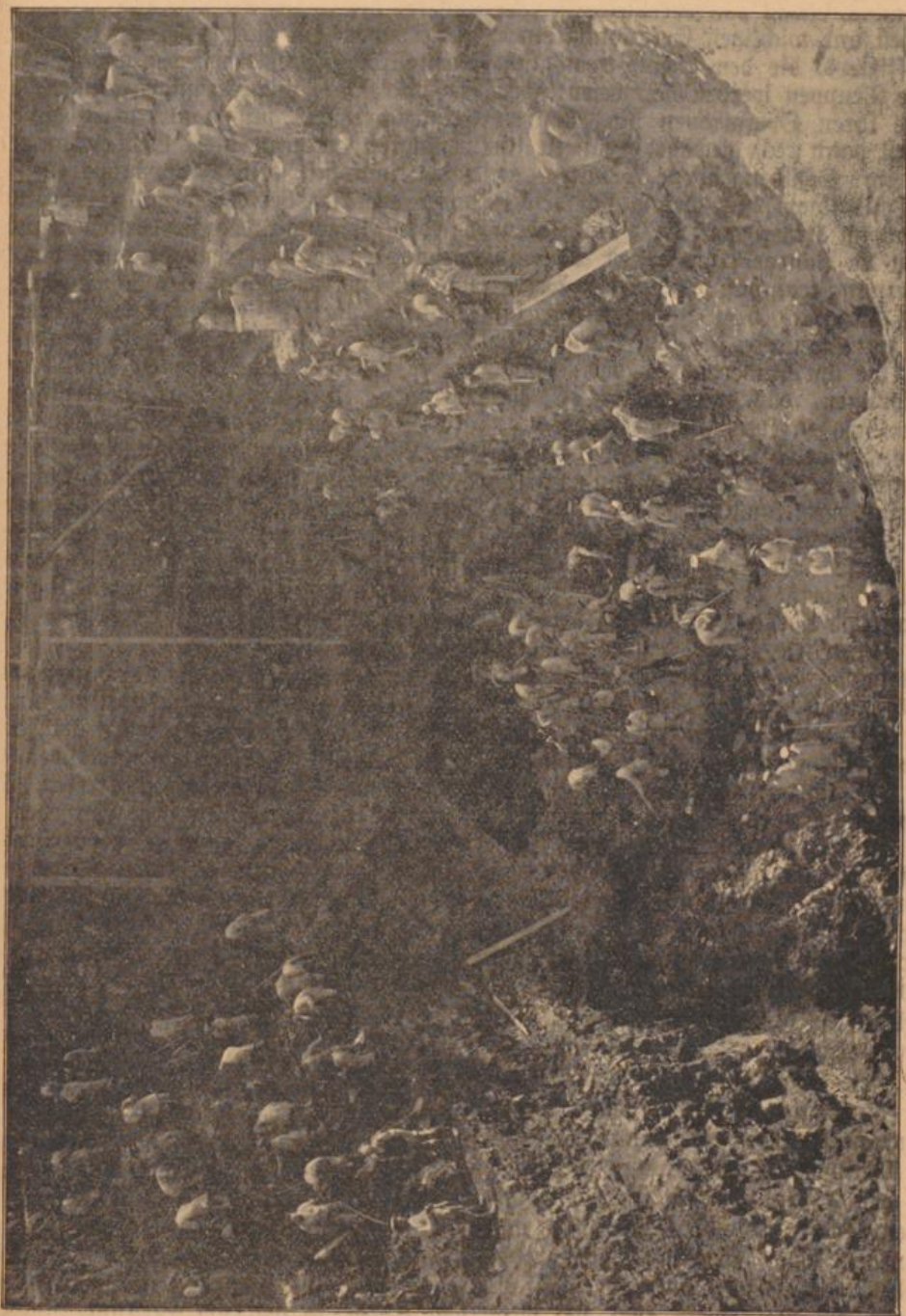
Ein von den Franzosen zur Führung unseeres Truppen- und Proviantwagens gestörter Eisenbahntunnel, an dessen Wiederherstellung Hunderte unserer Pioniere und Eisenbahner Tag und Nacht ununterbrochen arbeiten.
