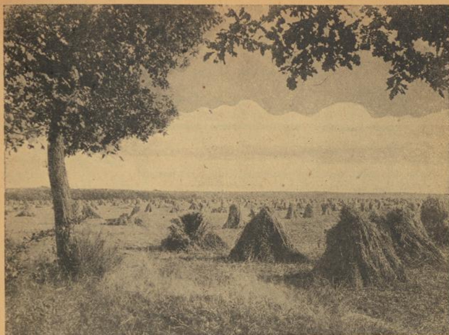
An dieser Stelle stand vor einigen Jahrhunderten ein alter germanischer Bauernhof
