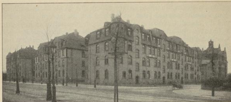
Fig. 11. Nordendblock in Frankfurt a. M.
