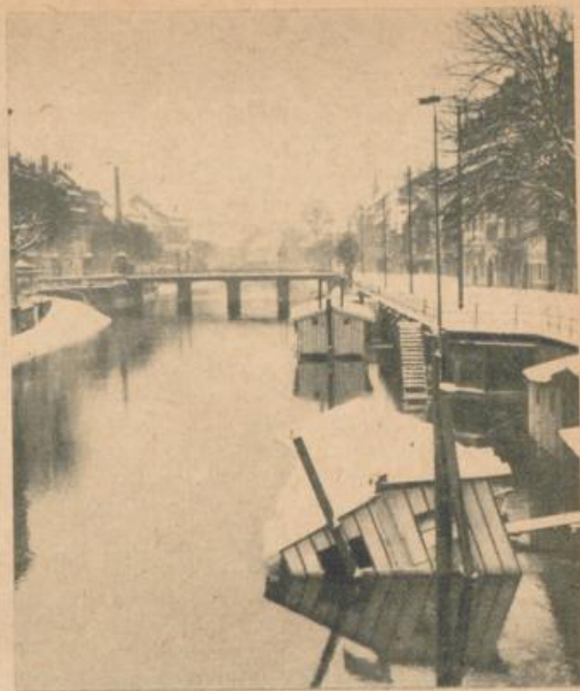
Die lecke Waschpötsche auf der Jill
