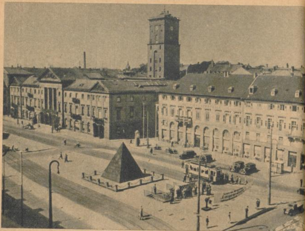
Adolf-Hitler-Platz in Karlsruhe in der Räumungszeit
