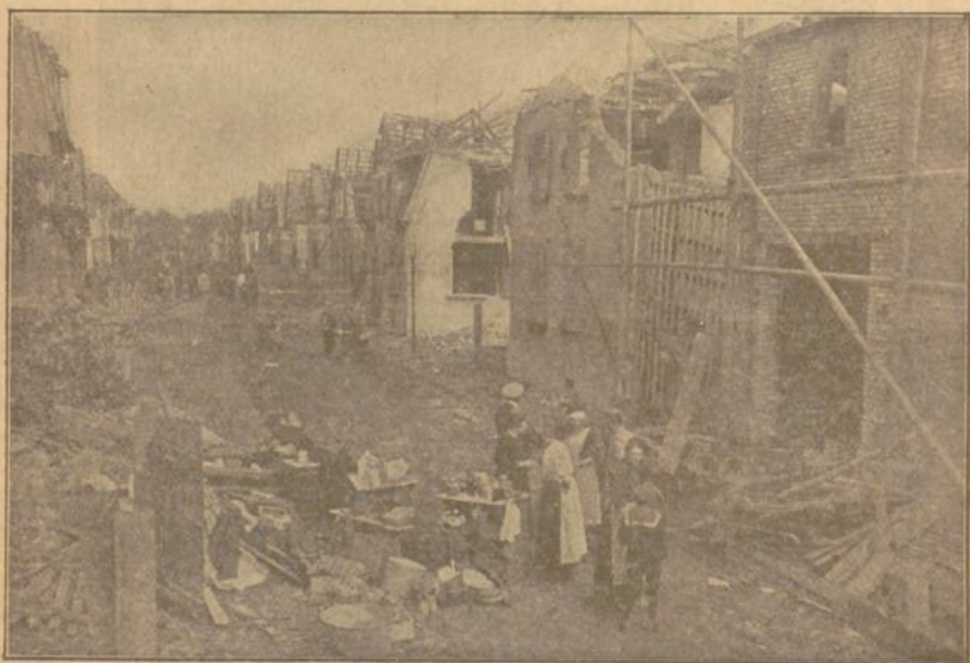
Blick über die Hauptstraße des zerstörten Oppau
