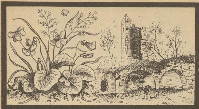
Ruine Groß-Geroldsee bei Zabern.
