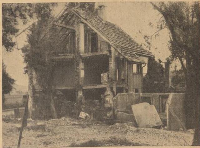
Durch unsinnige Sprengungen der Franzosen wurden viele Häuser im Elsass zerstört Aufn. Archiv
