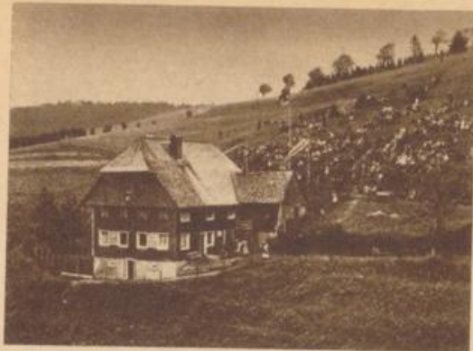
Die Karlobütte bei Furtwangen Zu einem Wanderheim umgebaut vom freiwilligen Arbeitsdienst des katb. Gesellenvereins Furtwangen
