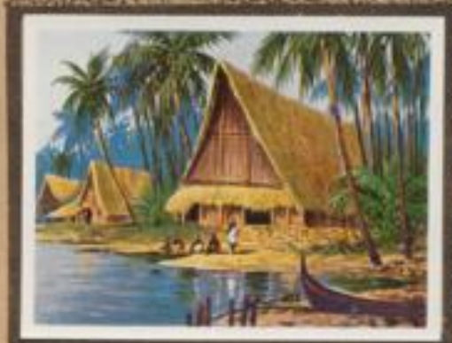
234 Gemeindefeldhaus auf Yap. Die Diebelseiten springen winkelförmig vor, so daß bei dem rechtwinkligen Innenraum auf beiden Seiten eine Veranda geschaffen wird. Die Bemalung fehlt hier im Gegensatz zu Palau.
