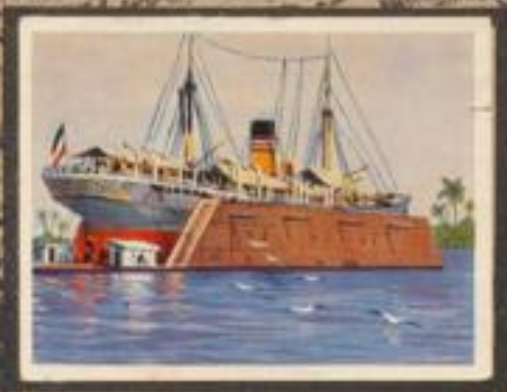
5 Kaiserin Wilhelmine in Dar es Salaam. Das von der Kolonialverwaltung in Dar es Salaam erbaute Kaiserin Wilhelmine ermöglichte es, die wichtigsten Schiffe anzuliefern. Sie war 64,5 m lang und hatte eine Tragfähigkeit von 1600 t.
