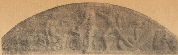
Giebfüllung am Esca-Bau.
