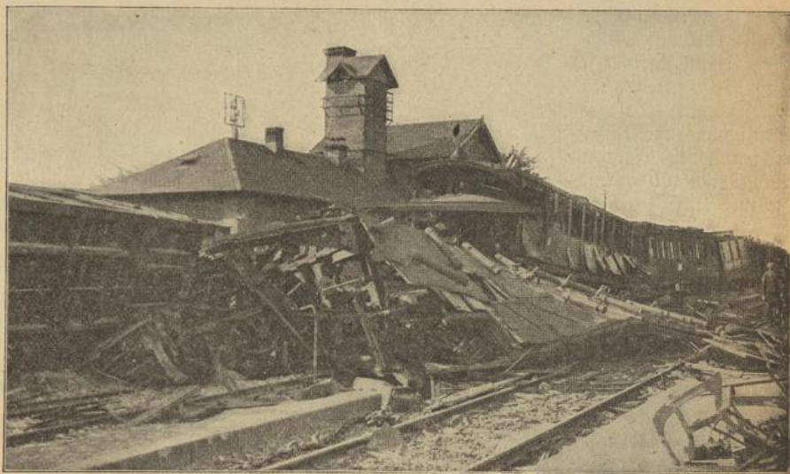
Die Entgleisung des Eilzugs Basel—Freiburg bei Müllheim in Baden.
