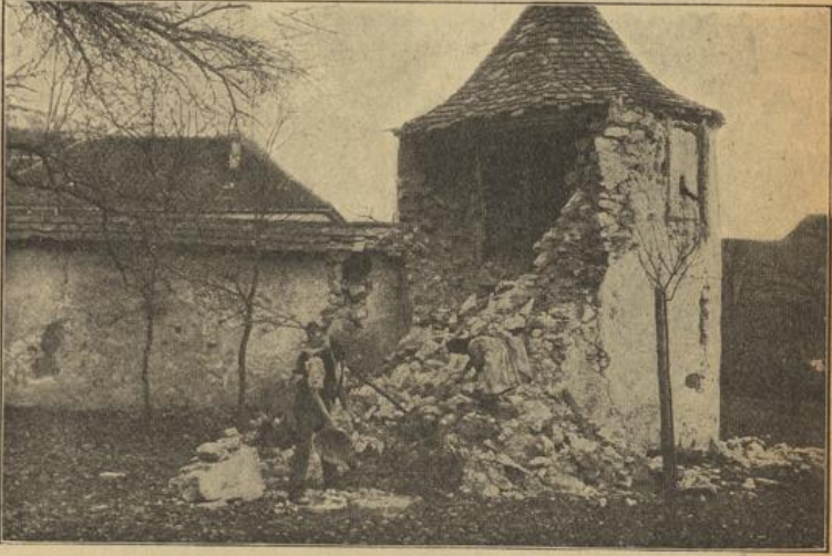
Erdbeben-Katastrophe in Süddeutschland am 16. November 1911: Der zerstörte Turm des Schlosses Staufenberg bei Lautlingen.
