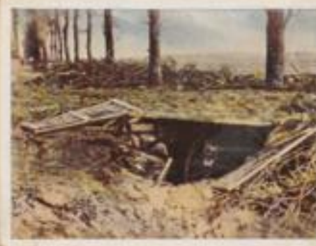
81 Weidkammer in Tarnung. Schätze kann man nicht nur späterlicher einbauen. Es mußte gerade bei der Artillerie gegen Luft- und Erdbeobachtung auf Tarnung besonders Wert gelegt werden. Man suchte sie zu erreichen durch unregelmäßige Aufstellung der Weidkammer, Verstellung früherer Weidkammern, Verjüngung aller Gänge und Trampelpfade sowie durch Anlage von Massen und Dörfern.
