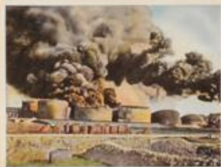
112 Brennende Petrolraumkoll. Um das für Kriegszwecke lebenswichtige Öl nicht in unsere Hand geraten zu lassen, haben die Rumänen bei ihrem Rückzug in der Walachei alle Lagerbestände erstickenden Tode an Brennstoffe der Petroleum und verheeren die Behälter. Dabei die Explosionen gelang es jedoch, einen großen Teil der Anlagen sehr schnell wieder in Betrieb zu setzen.
