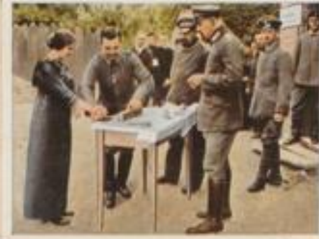
216 Bei einer Sammelstelle in der Stube. Der Erfolg der Front gegen Epizootie und die Gefahr von Epidemien und Schmutz erforderten eine sorgfältige Überwachung der Bevölkerung durch die Frontlinie. Um einer epidemischen Ausbreitung von Infektionskrankheiten vorzubeugen, wurde man sich bei den besten Hygienemethoden an.
