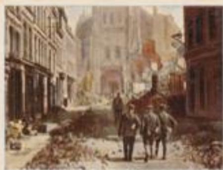
128 Kollaterale in St. Quentin. Nachdem im Frühjahr 1917 die Siegfriedfront besetzt war, lagen bei St. Quentin unsere Infanteriebatterien unmittelbar vor den Stadträndern. Die Artillerie fand in und hinter der Stadt. Diese wurde durch die richtige Beschießung hart getroffen. Besondere schwer ist die berühmte Kollaterale.
