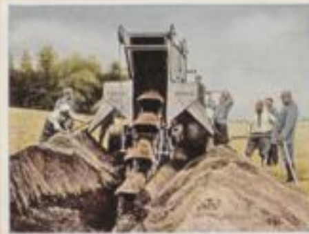
200 Französischer Heckenbagger. Zum Bau stützender Erddämme wurden auf beiden Seiten in großen Umfange Heckenbagger verwendet. Während dem Feinde außerdem durch Trümmerschutt aus seinen Kolonnen zur Verfügung kamen, wurde bei und neben Anmarschstrassen und Befestigungen die feindliche Truppe hart herausgepresst.
