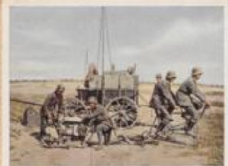
166 Versteckte Funkstationen. Zunächst kamen die „Zellen-Stationen“ nur für den Dienst der höheren Stufen. Bald aber wurde der Funktelegraph auch als Nachrichtenmittel innerhalb der Truppe verwendet, zunächst für den Verkehr zwischen Stützpunkten und Artillerie, schließlich aber auch zur Verbindung mit den vorderen Linien. Bei letzterem Zweck konnte der nötige Strom durch Wasserkräfte erzeugt werden.
