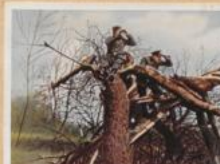
72 Baum-Beobachtung. Deshalb lagen die besten Stellen zur wehrkreise Beobachtung. Dagegen blieb aber bei Wehrkreise erhöht. In diesen Fall kam es sehr im Stellungskrieg hier und dort zu einer Intensivbeobachtung, ähnlich wie im Bewegungskrieg. Alle notwendigen Maßnahmen des Wehrkreises wurden hierbei natürlich sorgfältig ausgenutzt.
