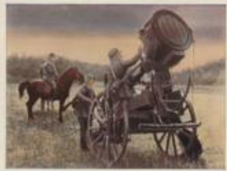
174 Schienenwagen, bereit zum Verladen. Die letzten Schienenwagen, mit denen unsere Schienenwagen für den Durchbruch, wurden im allgemeinen in den Fronten. Im Graben fanden meist mit einem oder zwei bis drei Handkutschenverfügen. Die größte Bedeutung gewann der Schienenwagen in der Flugabwehr. Bei der Verwendung man immer gewaltigeren Bedürfnis.
