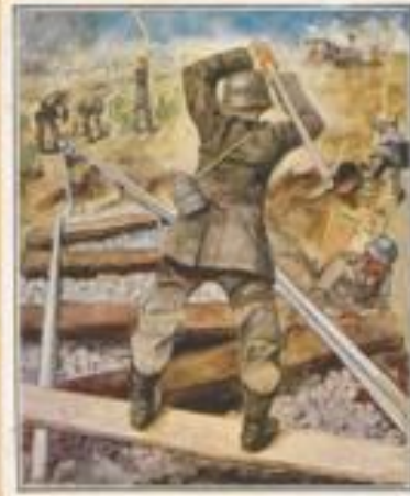
Eisenbahn-Regiment Nr. 3 Danau Bau-Kompanie bei der Arbeit
