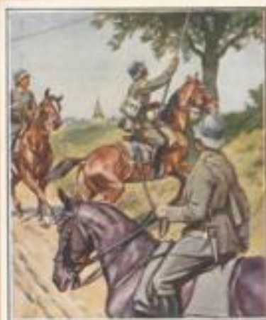
2. (Preussische) Nachrichten-Abteilung Stettin Neuzeitlicher Fernsprech-Leitungsbau
