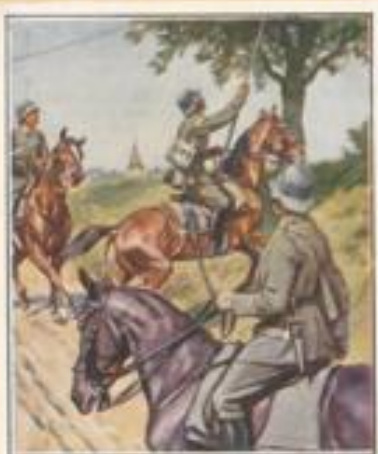
2. (Preussische) Nachrichten-Abteilung Stettin Neuzeitlicher Fernsprech-Leitungsbau
