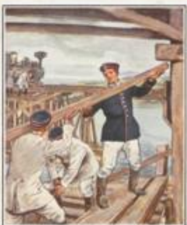
Eisenbahn-Regiment Nr. 1 Berlin Bau einer Feldbahnbrücke
