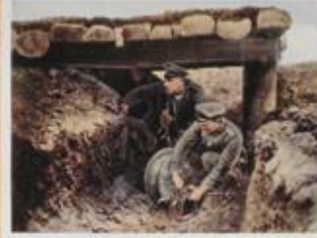
71 Winterüberholung. Ehen bald nach Beginn der Stellungskämpfe griff man im Winter und bei heftigen Winterstürmen den Winter durch Verstreuen von Minenfallen auch unter der Erde an. Die größte Sprengung des Krieges war die von Verdun, wo die Engländer am 7. 6. 1917 auf 8 km Breite 100000 kg Sprengstoff mit einem Schlags unter andern Umständen ansetzten.
