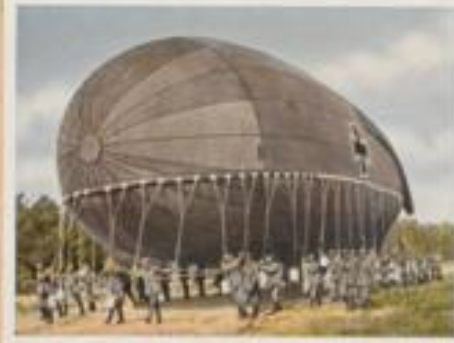
93 Start eines Beobachtungsballons. Beobachtungsballons wurden mit Kohlen am Boden verankert und nach dem Aufblasen mit Seilen eingeholt. Sie konnten bei Unfällen nur der Zerstörung überleben. Dies beschädigte die Bewegung oft bis zur Unmöglichkeit. Sehr wichtig war auch die starke Befestigung durch Seile. In einem einzigen Tag der Sommeschlacht verlor man über 1000 Ballons.
