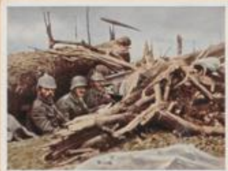
85 Grabgraben vor Verdun. Während des Verdun-Angriffs konnte sich unsere Infanterie nicht nur natürliche Deckung schaffen. Das unangelegte Artillerie- und MG.-Feuer auf Erhöhungen und Wege machte künstliche Schutz und das Herauschaffen von Material fast unmöglich. Weiter und tiefer zu graben die Schützengräben. Das trotzdem geschah wurde, war fast nicht möglich.
