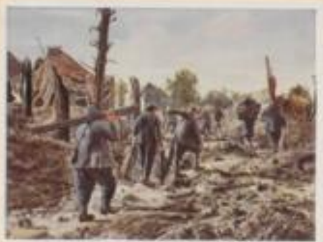
88 Französische Trägerkolonne bei Verdun. Der Kampf um Verdun verschlang ungeheure Mengen von Kriegsmaterial. Sein Transport war äußerst schwierig, da auch das Hintergründe ständig unter schwerem Feuer lag. Überholungen konnten im allgemeinen nur bis in die Mittelmittelnungen vorgeführt werden. Von da auf mußte man auf beiden Seiten alles vortragen.
