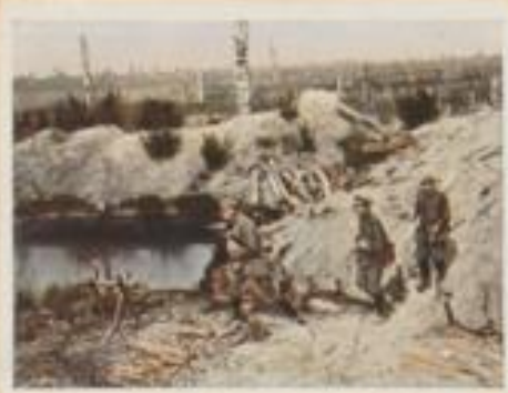
79 Vermessungstrupp. Im Stellungskrieg wurden für jeden Postenabschnitt genaue Karten gezeichnet. Die Unterlagen dieser Vermessungen, vorhandenes Kartenmaterial und Messinstrumente. Die Stellungskarten waren auch für das Schießen der Artillerie von großer Bedeutung. Man baute auf diesen Zeichnungen und Plänen genaue Feststellungen.
