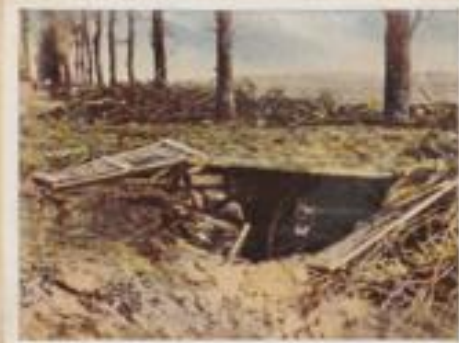
81 Weidkammer in Tarnung. Weidkammern kann man nicht nur spärlicher einbauen. Es mußte gerade bei der Artillerie gegen Luft- und Erdbeobachtung auf Tarnung besonderen Wert gelegt werden. Man suchte sie zu erreichen durch unregelmäßige Aufstellung der Weidkammern, Verstellung früherer Weidkammern, Verjüngung aller Gänge und Trampelpfade sowie durch Anlage von Massen und Büschen.
