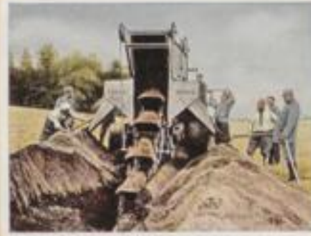
200 Französischer Dampfbagger. Zum Bau stützender Erddämme wurden auf beiden Seiten in großen Umfang Dampfbagger verwendet. Während dem Feinde außerdem durch Trümmerfelder aus seinen Kolonnen zur Verfügung kamen, wurde bei und neben Anmarschstrassen und Befestigungen die feindliche Truppe hart herausgepresst.
