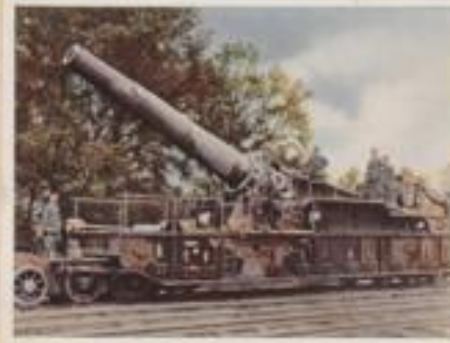
192 Scheutiger Eisenbahngeschütz. Im Verlauf des Krieges kamen auf beiden Seiten Eisenbahn- geschütze in Gebrauch. Ihre Länge ist ein schwerer Eisen- bahngeschütz. Sie haben den Vorteil der raschen Ortsver- änderung. Der Schuß kann allerdings nur in Richtungen über wenig Stück davon abgegeben werden. Unter dem Jahrgang eine franz. Kanone, die aus und in der Mist-Chiffre erbeutet wurde.
