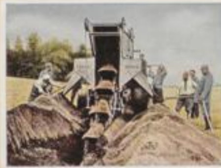
200 Französischer Heckenbagger. Zum Bau stützartiger Erhöhungen wurden auf beiden Seiten in großen Umfange Heckenbauern verwendet. Während dem Feinde außerdem durch Trümmerschutt aus seinen Kolonnen zur Verfügung kamen, wurde bei und neben Anmarschstrassen und Befestigungen die feindliche Truppe hart herausgepresst.
