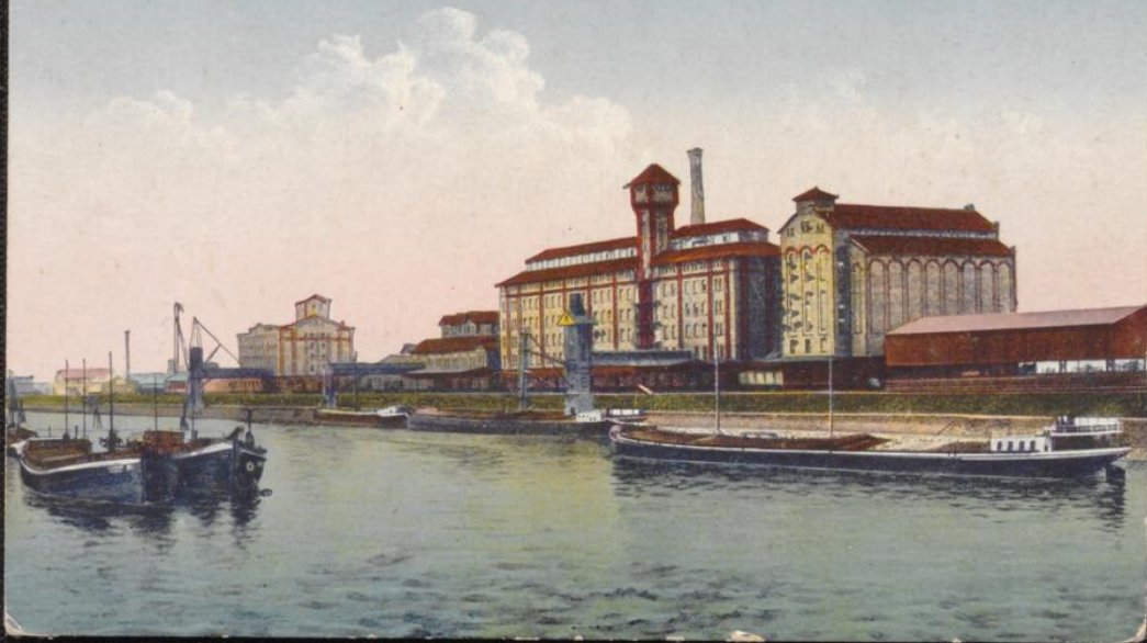
MANNHEIM. Hafenpartie. Mühle von H. Hildebrand & Söhne.
