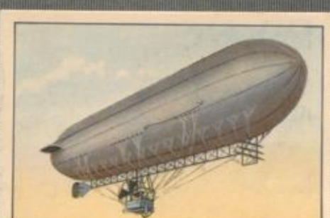
Nr. 6 Ruthenberg-Luftschiff Kleines halbstarres Luftschiff von 1200 cbm Inhalt mit 24-PS-Motor. Es erhielt auf der Ila den Preis für das kleinste Luftschiff.
