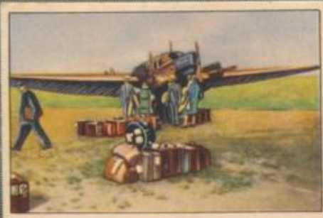
Nr. 17 Junkers G 24 L Verkehrsflugzeug auf Landfahrgestell, Kabine für 12 Fluggäste. 3x310-PS-Junkers L 5 Motoren, wassergekühlt.
