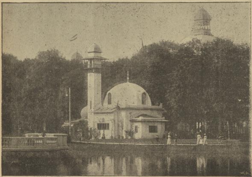
Pavillon : Elsäffische Conservenfabrik.
