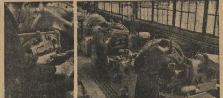
Modernste amerikanische Zahnrad-Bearbeitungsmaschinen sorgen im Werk Untertürkheim für genauesten Schluß (oben) der Zahnflanken und damit für die Geräuschlosigkeit der bewährten Mercedes-Benz-Geläube und Hinterachsen
