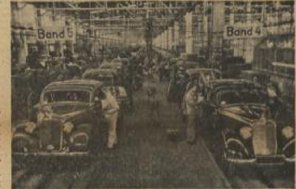
Die Bänder 4 und 5, auf denen die Wagen nach Fertigstellung und Probefahrt noch einmal lackiert und poliert werden
