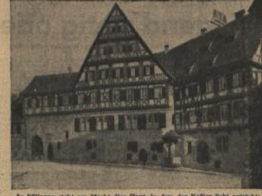
In Eßlingen steht am Markt das Haus, in dem der Kefler-Sekt entsteht; im Vordergrund der wiedererrichtete Renaissance-Brunnen
