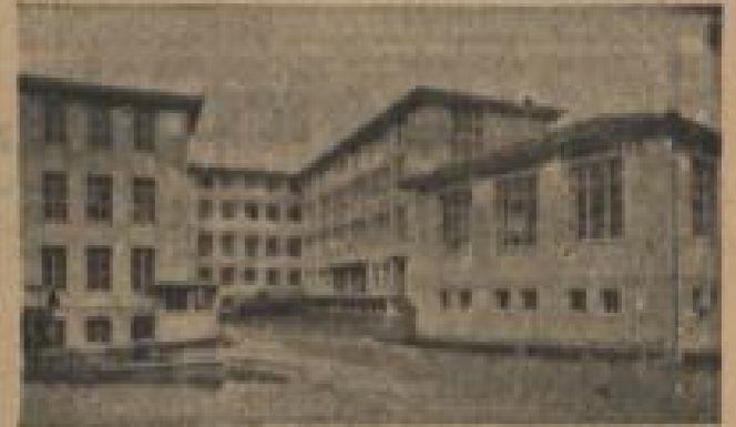
Blick in den Fabrikhof, rechts hinten die Rückfront des Verwaltungsgebäudes
