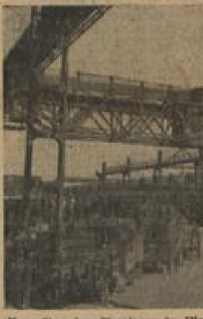
Kran über dem Eisenlager; im Hintergrund die Mähmaschinenmontagehalle
