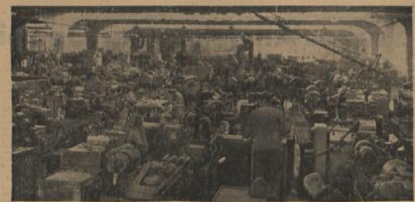
Ein Blick in die große Maschinenhalle
