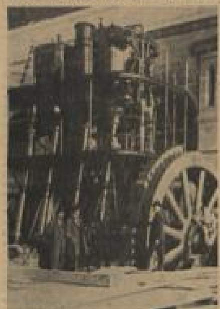
Erste Kolbendampfmaschine des RWE, 1796 Pfl. aus dem Jahre 1803 in der Zentrale Viehoferstraße Essen
