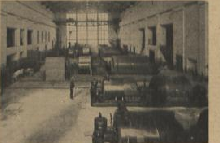
... und nach dem Wiederaufbau
