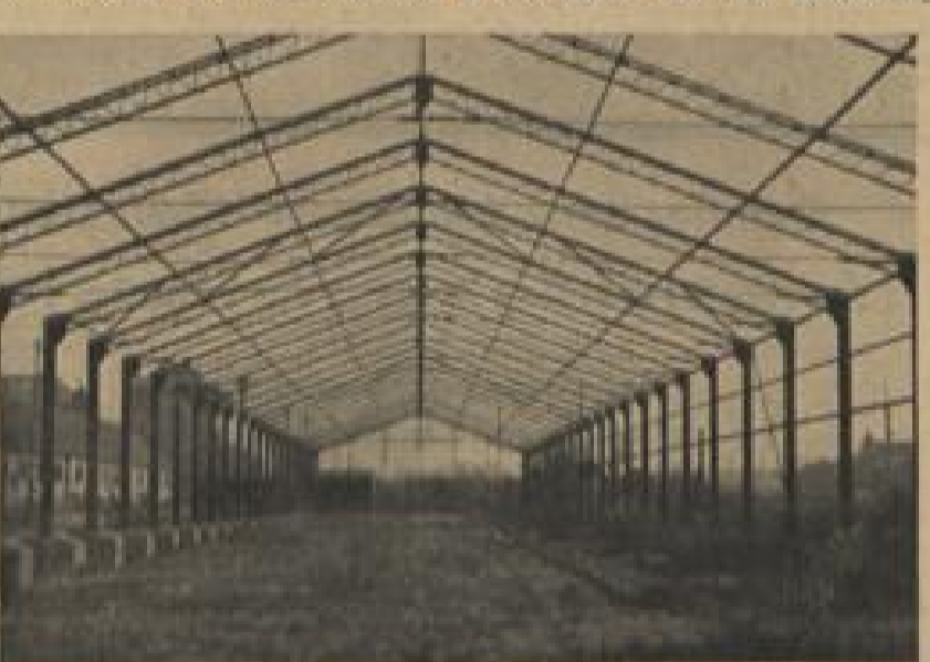
Dachkonstruktion in Filigran-Leichtbauweise für eine Halle
