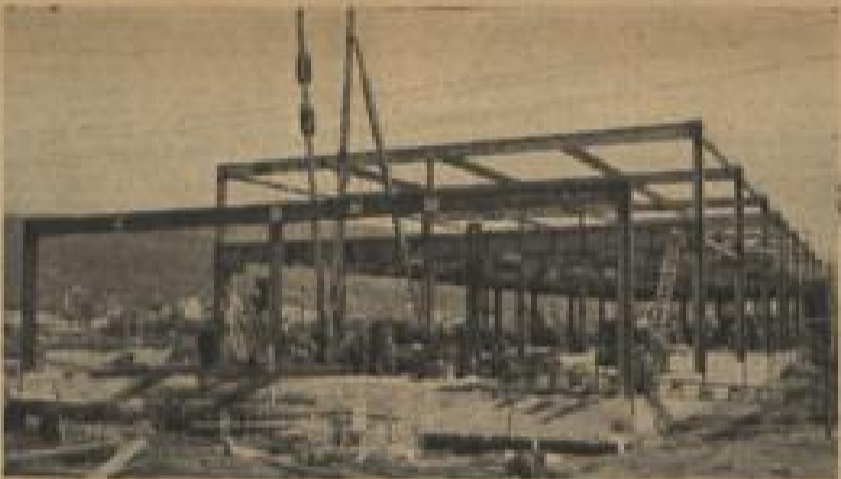
Stahlskelett für ein Fx-Warenhaus
