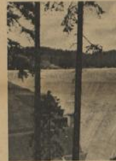
Staumauer des Schluchsees (Höhe 60 m)
