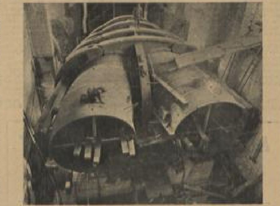
Das Eisenrohr für das Kraftwerk Waldhut bei der Montage; gebaut von der Dortmunder Union, Werk Orange, Gelenkbrücken
