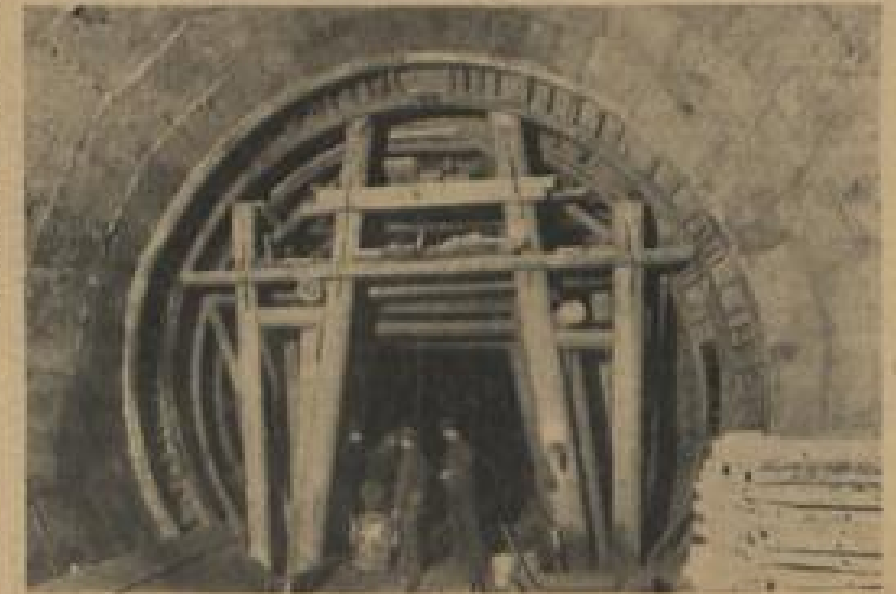
Rheinstollen Witznau-Waldhut im Bau (Länge 5,5 km, Durchmesser 4 m) gebaut von der Süddeutschen Tunnelbau-Ges. Singer & Lüssinger, Baden-Baden
