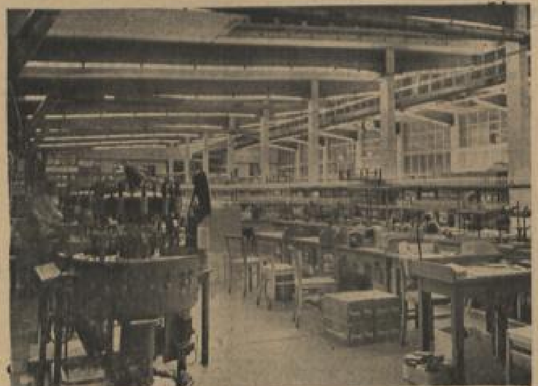
Ein Arbeitsraum im Werk Herbrechtingen
