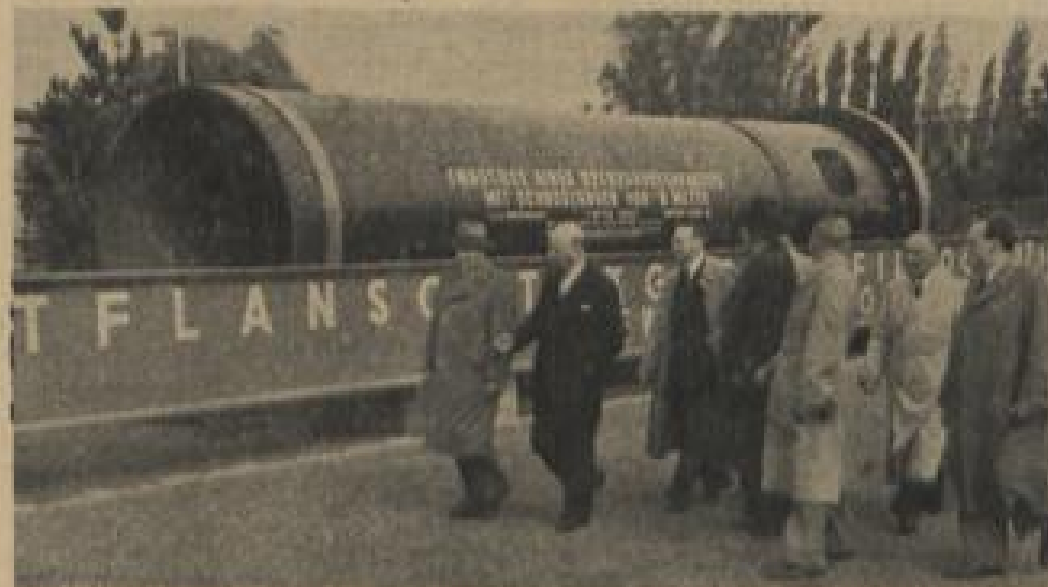
Im Vordergrund Teilansicht des 37 m langen und 1 m breiten Breiflanssträgers, einer Hochleistung von Heide-Peine, dahinter Endstück eines Drehofenpanzers mit Schmelzflüssen von 8 m (Hüttenwerk Hübner)
