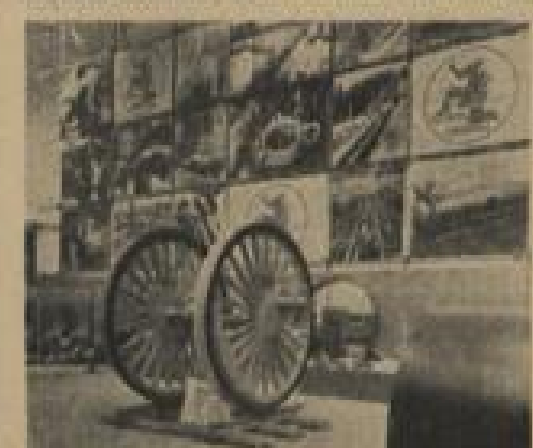
Radetzki für moderne Schnellzuglokomotive; Laufkreisdurchmesser: 2300 mm, Gewicht: 2600 kg (Bochumer Verein)
