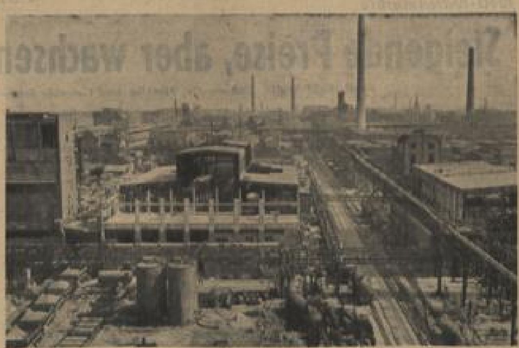
Tollansicht des Werks; im Hintergrund die Stadt Ludwigshafen
