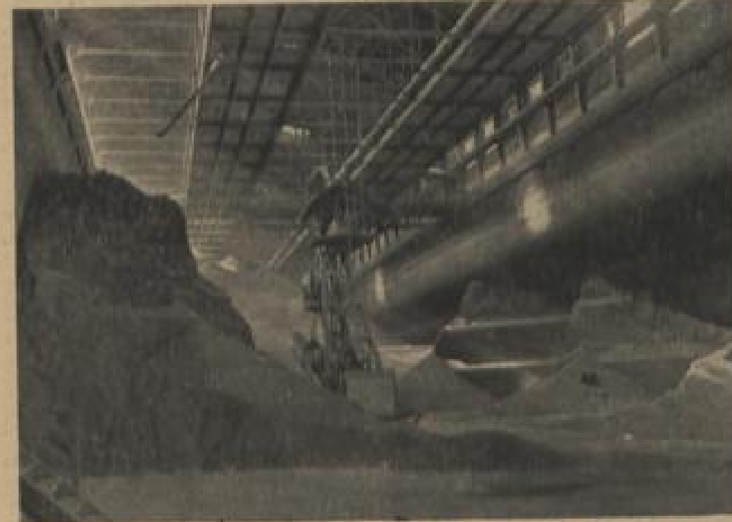
Band 60.000 t Fassungsvermögen hat das größte der sieben Silos des Werks, in denen sich die Stickstoff-Düngemittel zu Bergen türmen
